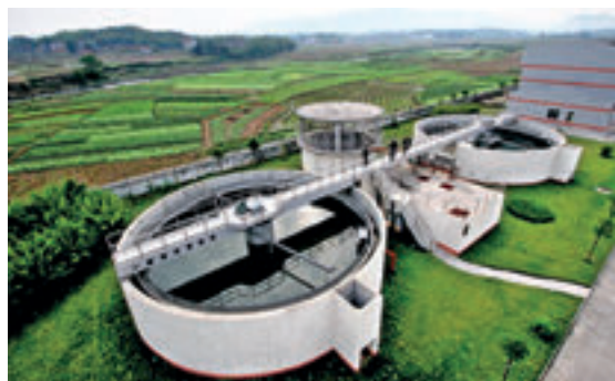
临湘市桃矿独立工矿区污水处理厂一角。
