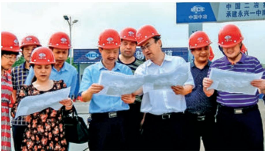
永兴县人大常委会主任陈晓云带队到永兴一中南校区项目建设现场视察。
