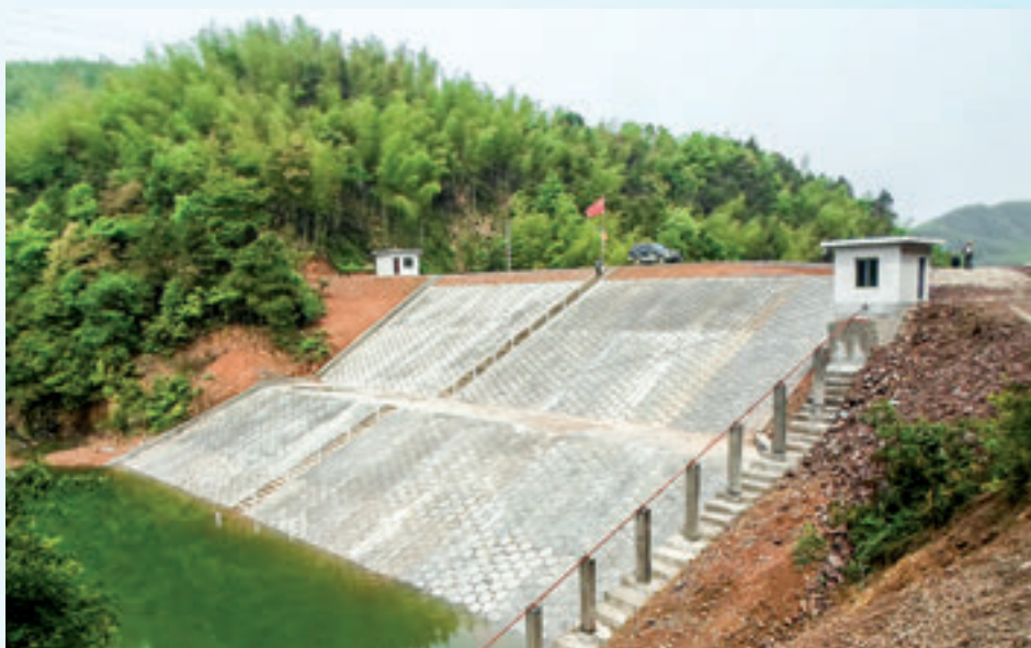
除险加固后的芭茅村水库。
