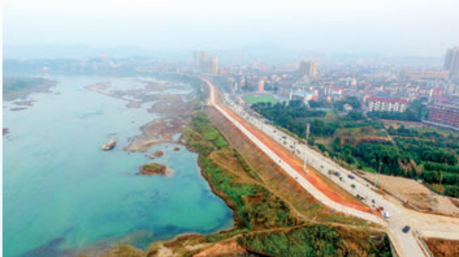
除险加固后的城关垸大堤。
