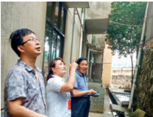
常育丰（中）察看修好后的龙长学校维护墙。
