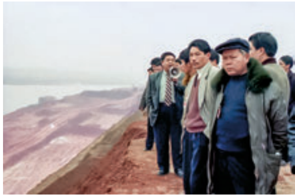
1999年11月，汨罗市八届人大常委会开展防洪法执法检查，组织代表视察汨罗江水利工程。
