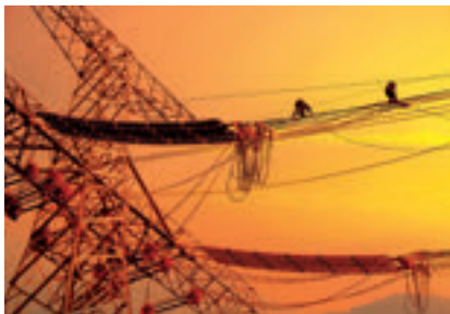
酒湖线建设现场。
