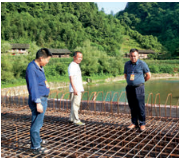
彭清东（右一）视察龙山县洗车河镇谢家寨桥建设情况。
