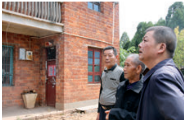
倪小平（右一）与张顺生老人商量解决房屋漏水的办法。
