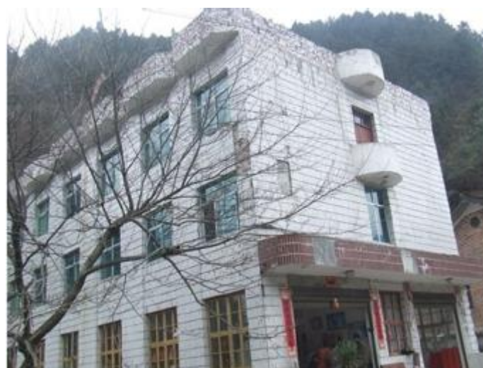
管理处建筑现状
